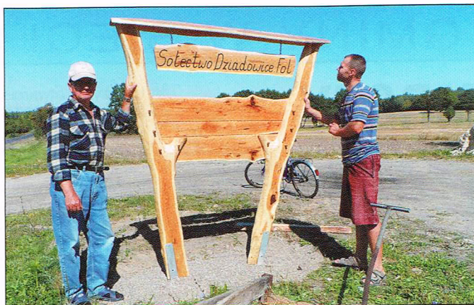
Prace przy ustawianiu tablicy informacyjnej.
