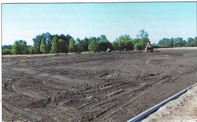
Wiele wysiłku włożono w budowę boiska sportowego.
